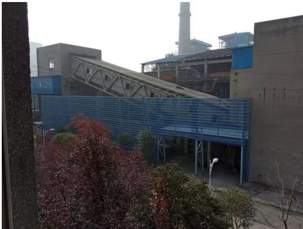
2#锅炉输煤栈桥拆除前
