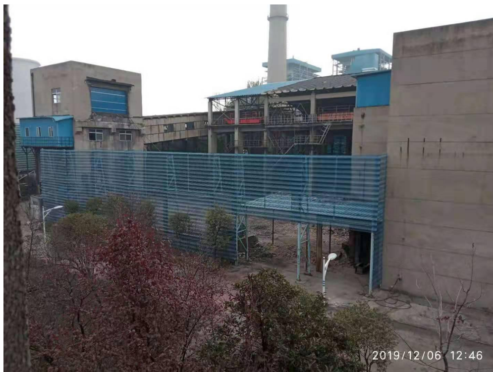
2#锅炉输煤栈桥拆除后
